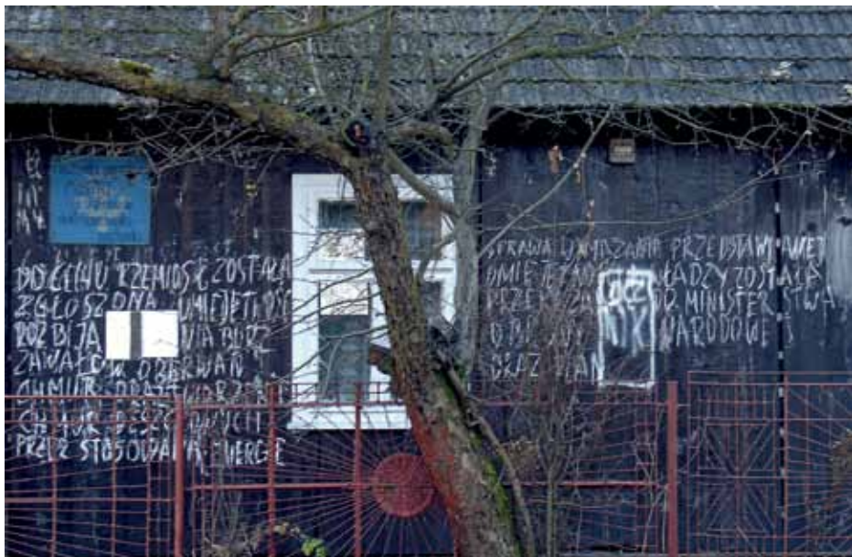
Ściana frontowa domu (autor M. Wójtowicz-Wierzbicka).
