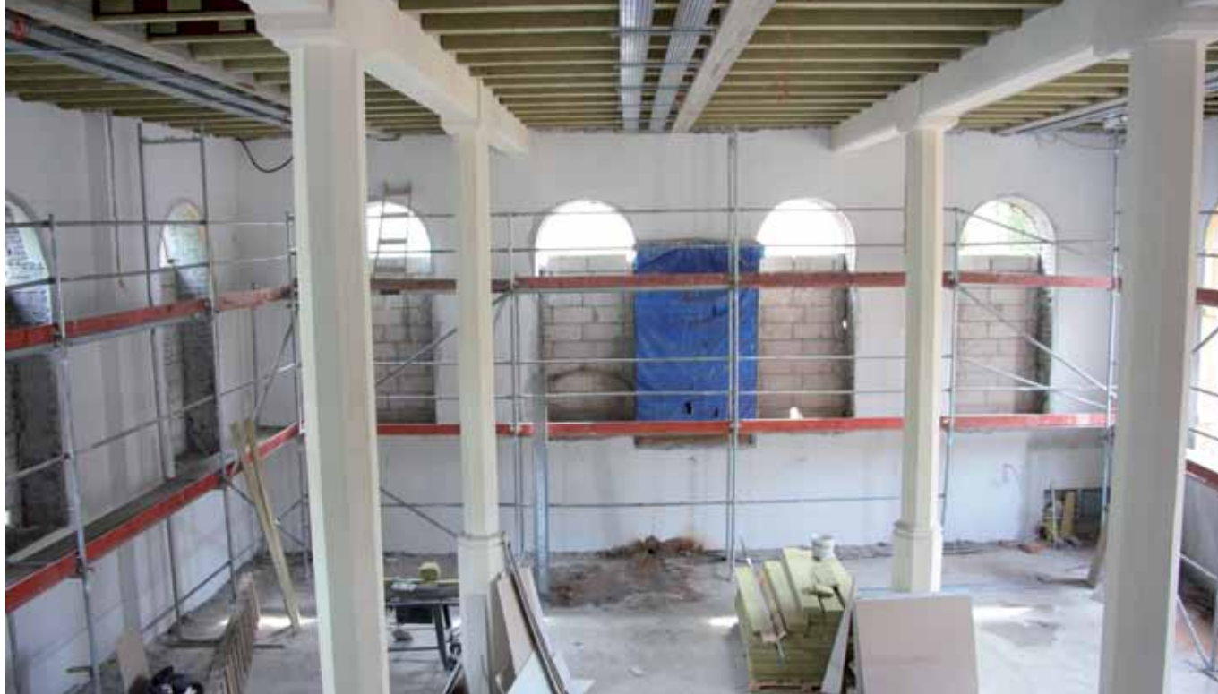
Wnętrze bożnicy, czerwiec 2012.
