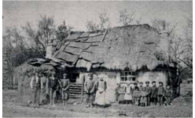
Chlew w Święcicach zamieniony na budynek mieszkalny.
